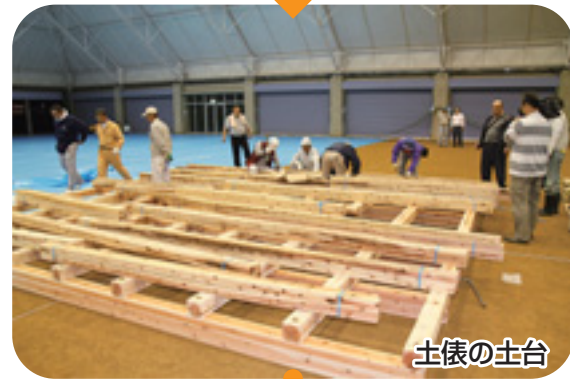
土俵の土を搬入
