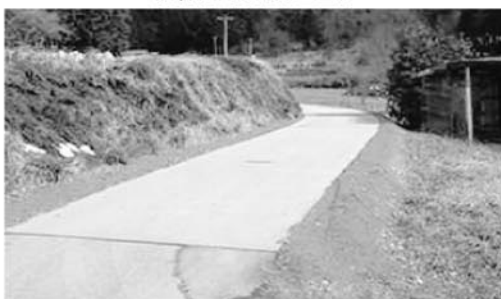
農道築原線舗装工事
