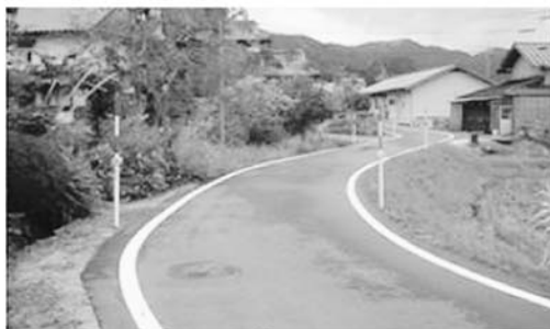
視線誘導標設置工事
