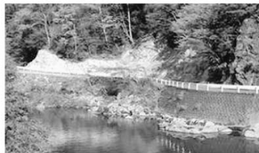
町道久田泉線法面改良工事
