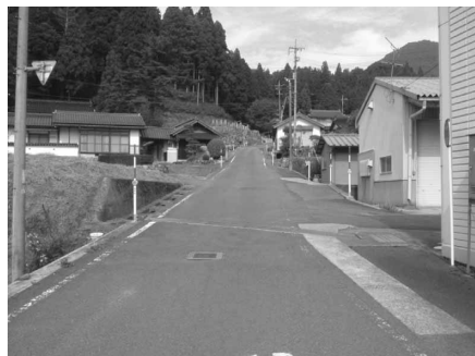
視線誘導標設置工事
