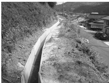
大井出水路改良工事
