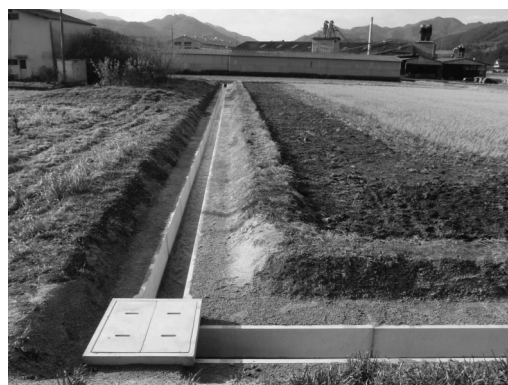
石橋水路改良工事
