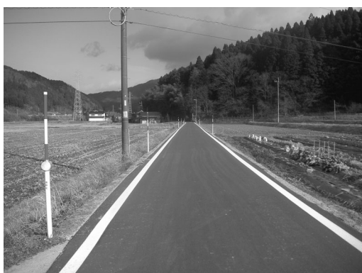
視線誘導標設置工事
