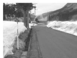
視線誘導標設置
