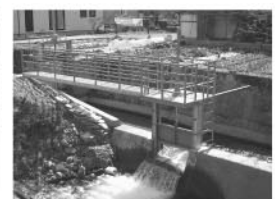
山城水路修繕
