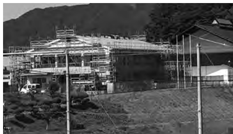
▲改修が進む給食調理場
