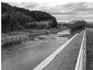
▲古川・岡坊地区の香々美川護岸工事
