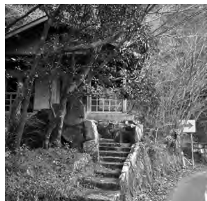
▲奥津溪トイレ
