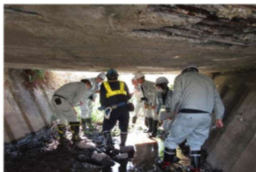
橋梁点検実習状況
