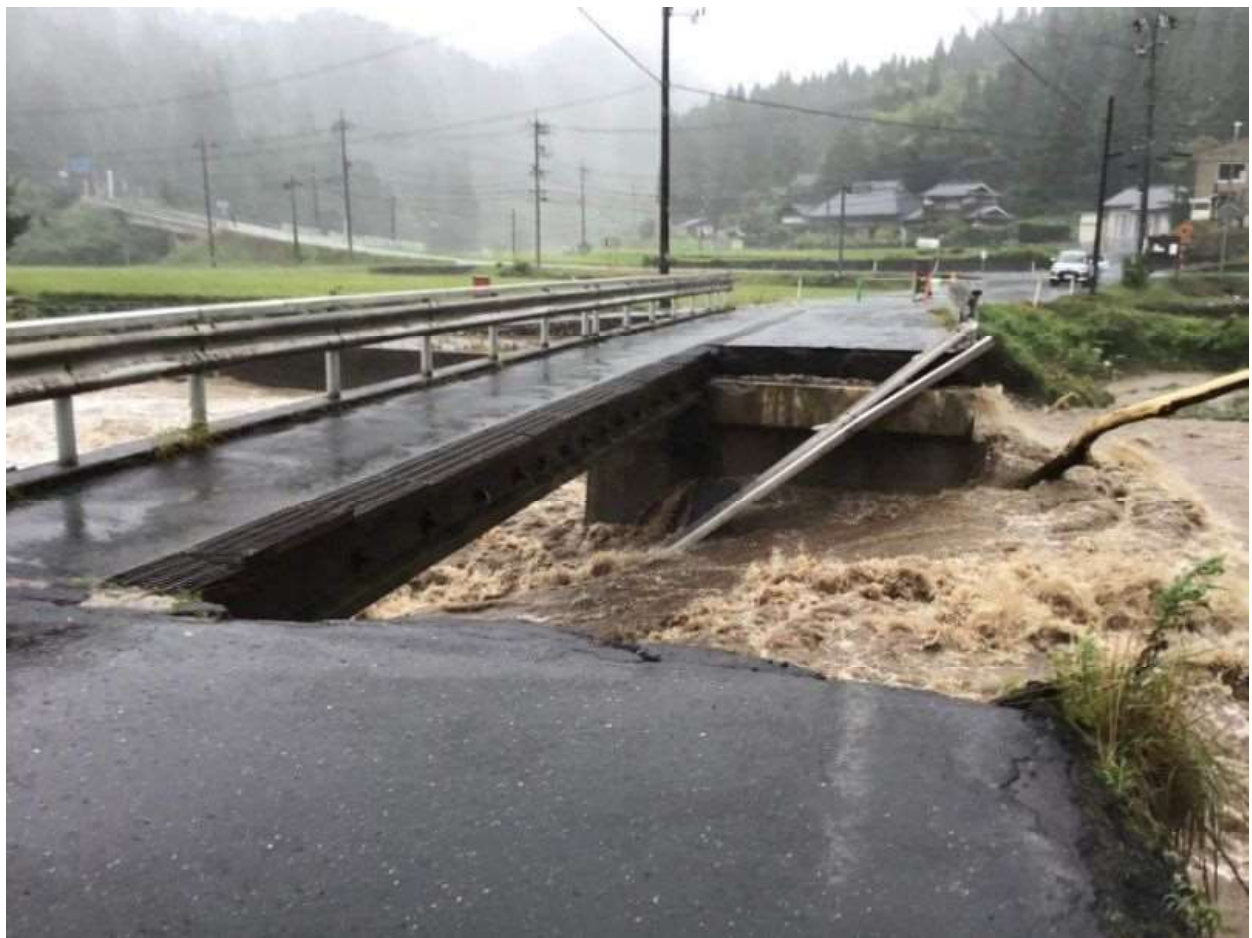
◆ 吉井川・大石大木山橋(上齋原)における令和 5 年台風第 7 号時の洪水状況
