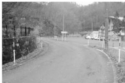
上齋原視線誘導標設置工事
