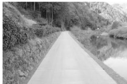
農道築原線舗装工事
