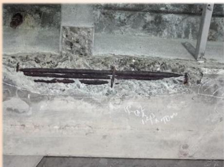
損傷内容： 主桁の鉄筋露出
