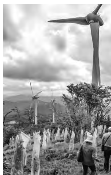
徳島県 ユーラス上勝神山ウインドファーム
