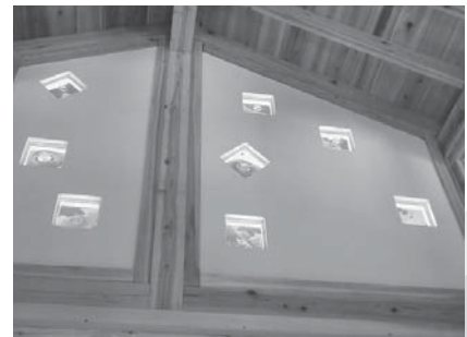
中から見た妖精の森ガラスの明り取り窓
