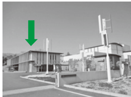
手前の施設の1階です
