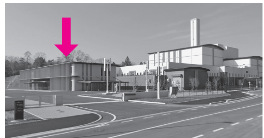
手前の施設の1階です
