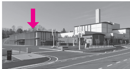
手前の施設の1階です
